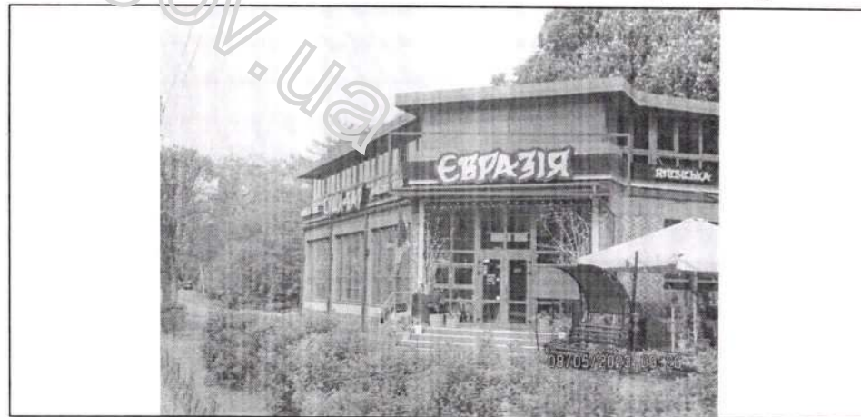
Фото фіксація розміщення спеціальної тимчасової/стаціонарної конструкції:
