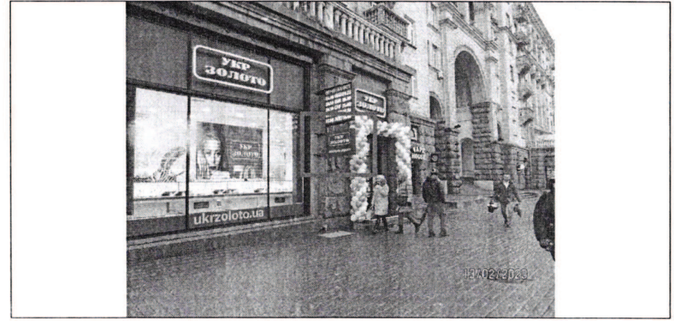
Фото фіксація розміщення спеціальної тимчасової/стаціонарної конструкції:
