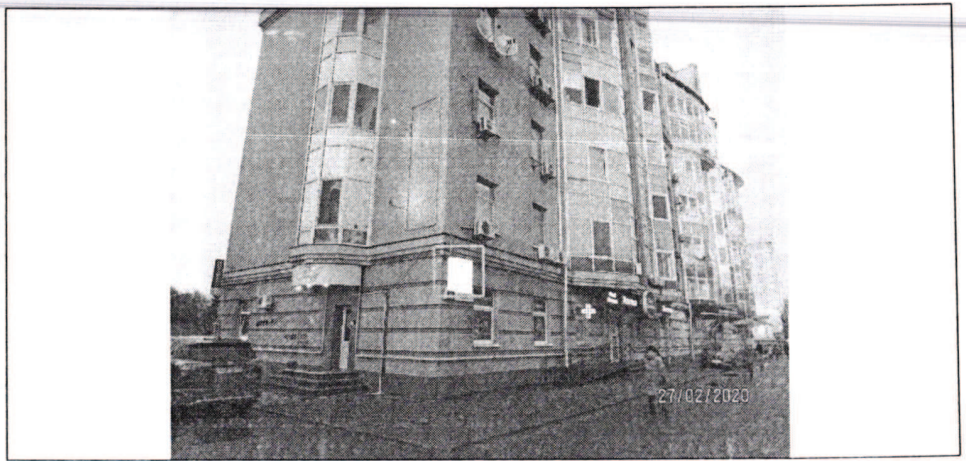
Фото фіксація розміщення спеціальної тимчасової/стаціонарної конструкції:
