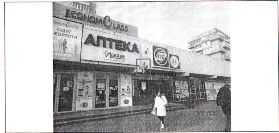
Фото фіксація розміщення спеціальної тимчасової/стаціонарної конструкції:
