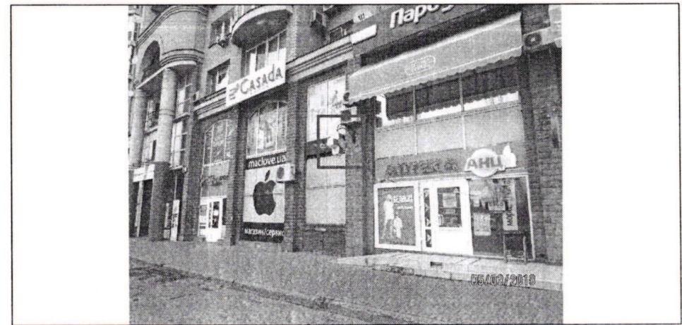
Фото фіксація розміщення спеціальної тимчасової/стаціонарної конструкції:
