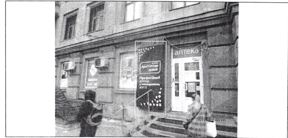
Фото фіксація розміщення спеціальної тимчасової/стаціонарної конструкції:
