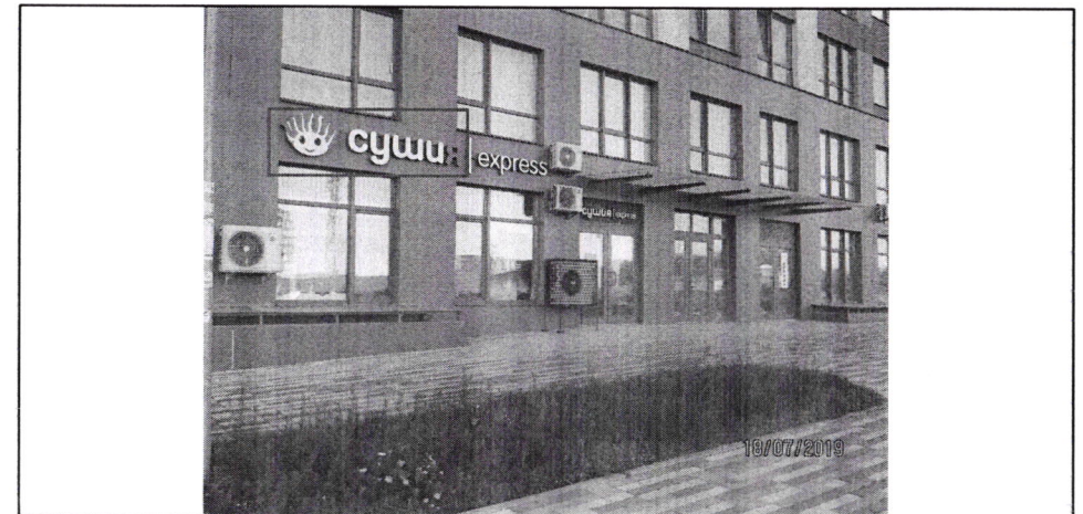
Фото фіксація розміщення спеціальної тимчасової/стаціонарної конструкції:
