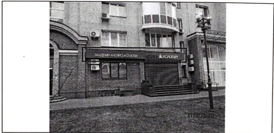
Фото фіксація розміщення спеціальної тимчасової/стаціонарної конструкції:
