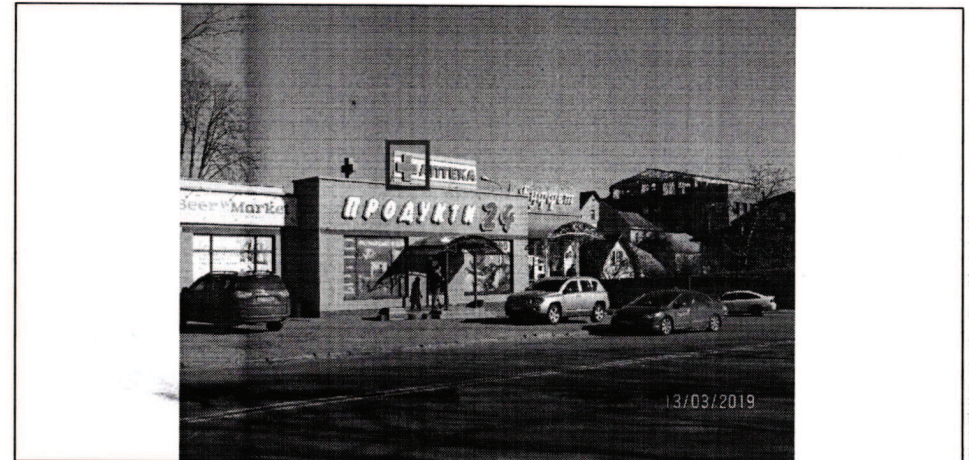
Фото фіксація розміщення спеціальної тимчасової/стаціонарної конструкції:
