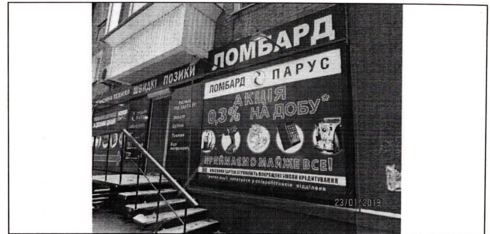
Фото фіксація розміщення спеціальної тимчасової/стаціонарної конструкції:
