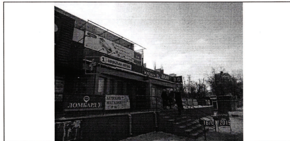
Фото фіксація розміщення спеціальної тимчасової/стаціонарної конструкції:
