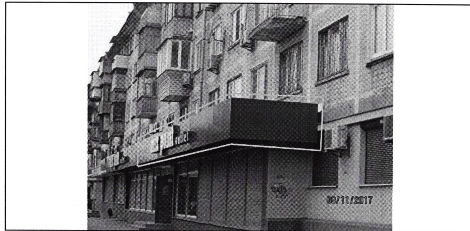
Фото фіксація розміщення спеціальної тимчасової/стаціонарної конструкції:
