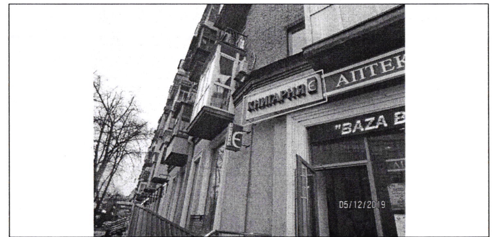
Фото фіксація розміщення спеціальної тимчасової/стаціонарної конструкції:
