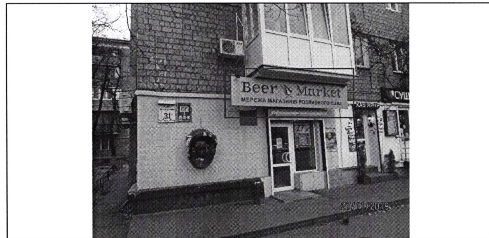
Фото фіксація розміщення спеціальної тимчасової/стаціонарної конструкції:
