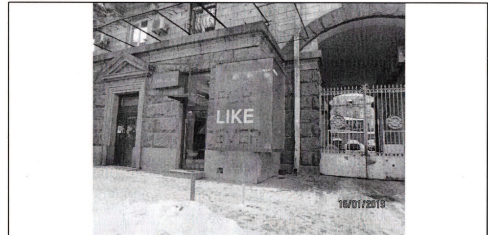
Фото фіксація розміщення спеціальної тимчасової/стаціонарної конструкції:
