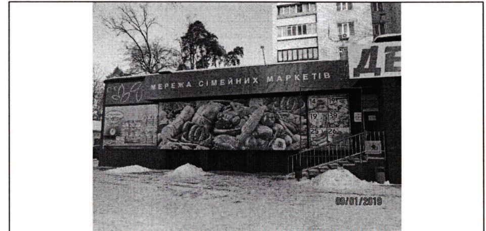
Фото фіксація розміщення спеціальної тимчасової/стаціонарної конструкції:
