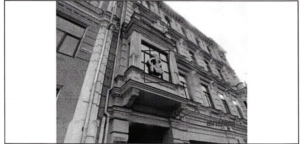
Фото фіксація розміщення спеціальної тимчасової/стаціонарної конструкції:
