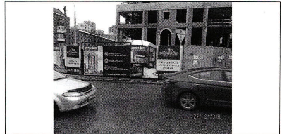
Фото фіксація розміщення спеціальної тимчасової/стаціонарної конструкції:
