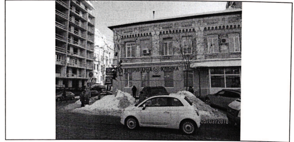
Фото фіксація розміщення спеціальної тимчасової/стаціонарної конструкції:
