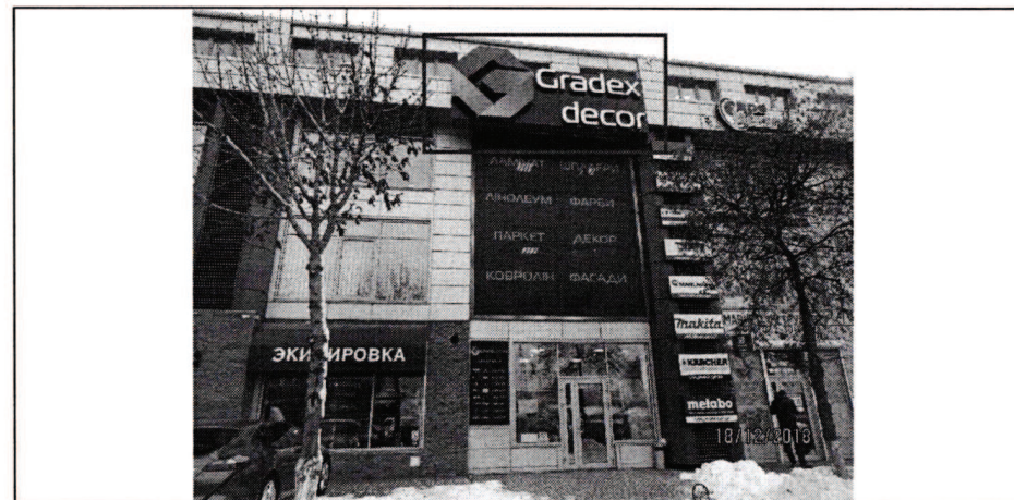
Фото фіксація розміщення спеціальної тимчасової/стаціонарної конструкції:
